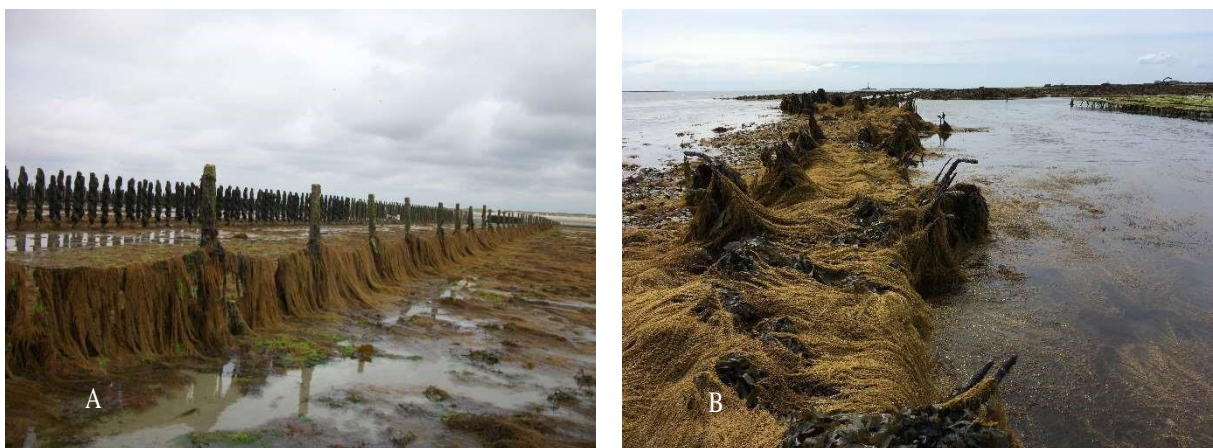
Figure 5 : Barrages « sauvages » pour lutter contre les échouages printaniers de sargasse : rangée d'orins tendus entre des poteaux (A), avec des tables à huîtres retournées (B) – Sites de Bricqueville-sur-Mer et Gouville-sur-Mer.
